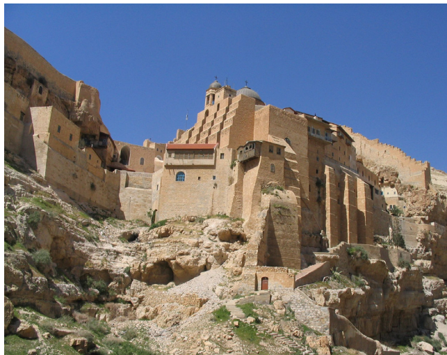
Mury monasteru, harmonijnie wtopione w pustynny krajobraz. Widać ślady wiekowych umocnień, dobudowane kielie.
