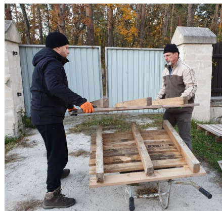
Porządkowanie terenu budowy monasterskiego domu.
